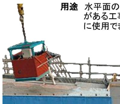
**用途** 水平面のコンクリート打ち継ぎがある工事で、薬剤等の散布に使用できます。
