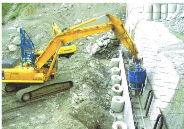
**特長** 掘削機の油圧で攪拌しながら、打設箇所まで運搬できます。
